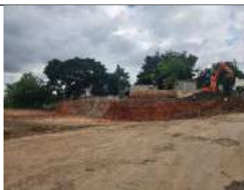
Foto 62 – Processo de limpeza do passivo ambiental de RCC existente na área da Secretaria de Obras e Serviços Urbanos
