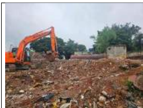
Foto 61 – Processo de limpeza do passivo ambiental de RCC existente na área da Secretaria de Obras e Serviços Urbanos
