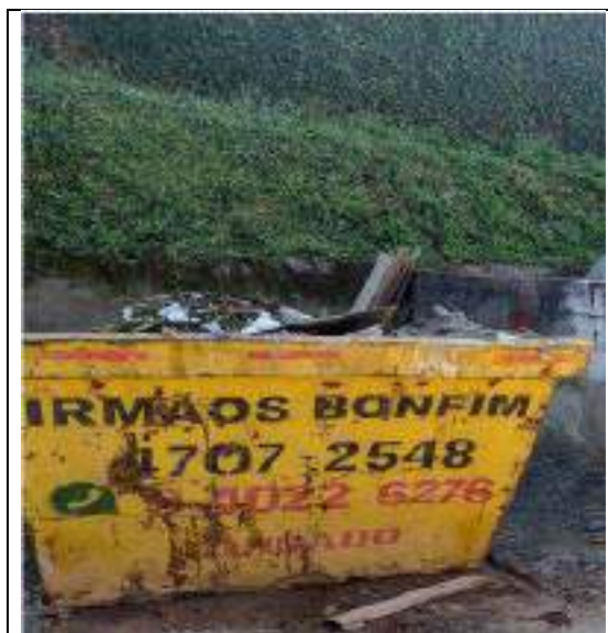
Foto 51 – Caçamba para armazenamento de RCC
